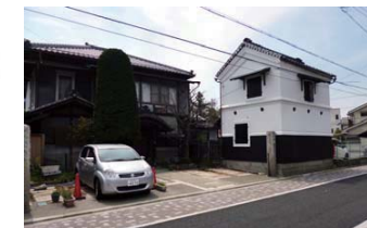
補修して守られてきた趣ある建物
