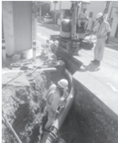
水道管の耐震化工事（安原地区）
