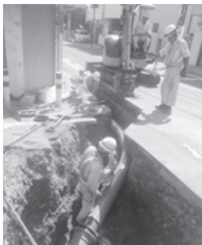
水道管の耐震化工事（安原地区）
