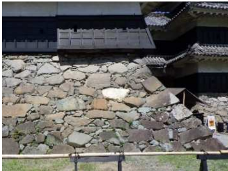
写真1) 野面積みの例：天守台東面の石垣 （文禄期と推定）
