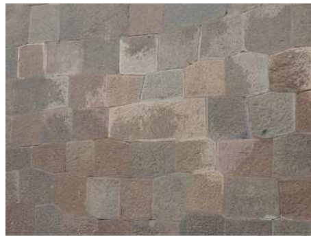
（参考）他城郭における切込み接ぎの例 金沢城石川門の石垣（西側～北側）
