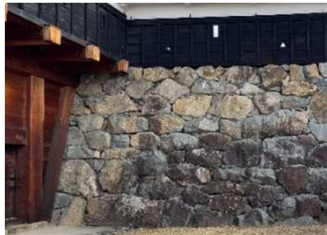
写真3) 打込み接ぎの例：太鼓門北台南面の石垣（昭和以降）
