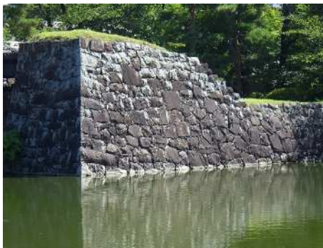
写真4) 切込み接ぎの例：埋門虎口南面の石垣 （江戸中期と推定）
