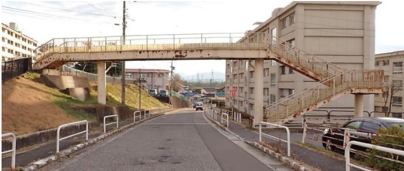
写真 5.1 並柳横断歩道橋
