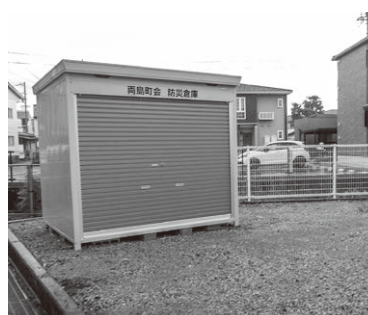
新しい防災倉庫
