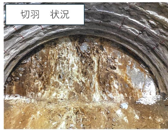
■終点側坑口より70m付近 切羽状況
