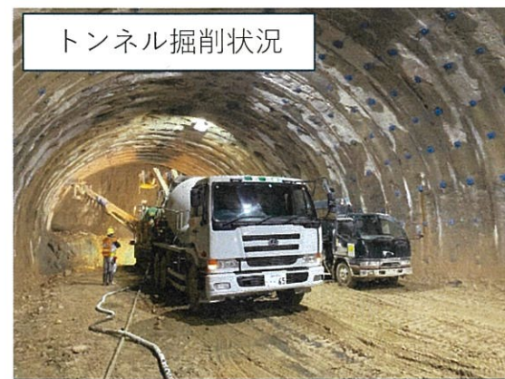
■終点側坑口より70m付近 トンネル掘削状況
