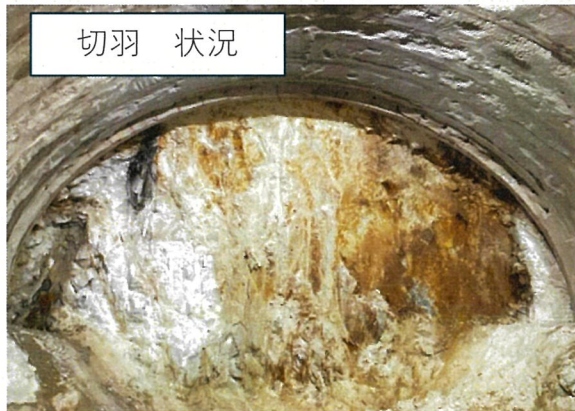
■終点側坑口より37m付近 切羽状況
