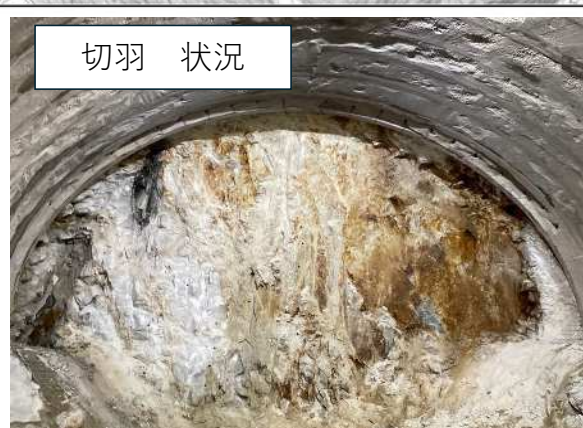
■終点側坑口より37m付近 切羽状況
