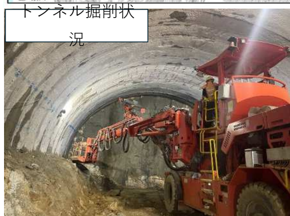
■終点側坑口より35m付近 トンネル掘削状況
