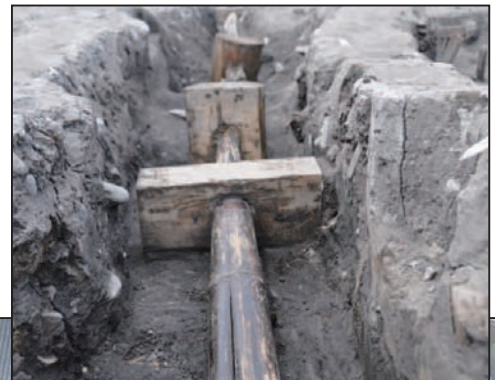
竹で造られた水道管と木製のジョイント
