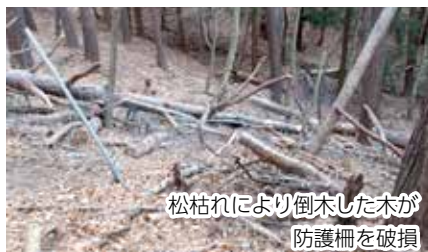
平成21年設置の防護柵
