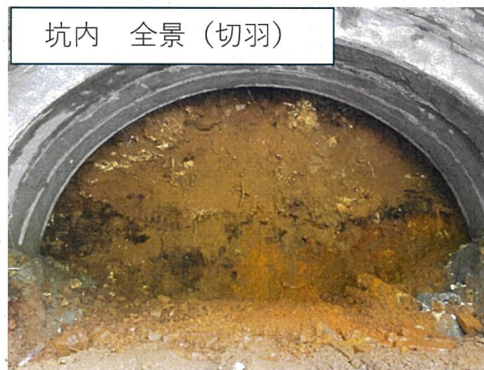
■終点側坑口より15m付近 掘削後の坑内（切羽）全景
