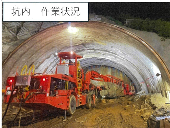
■終点側坑口より15m付近 掘削作業状況
