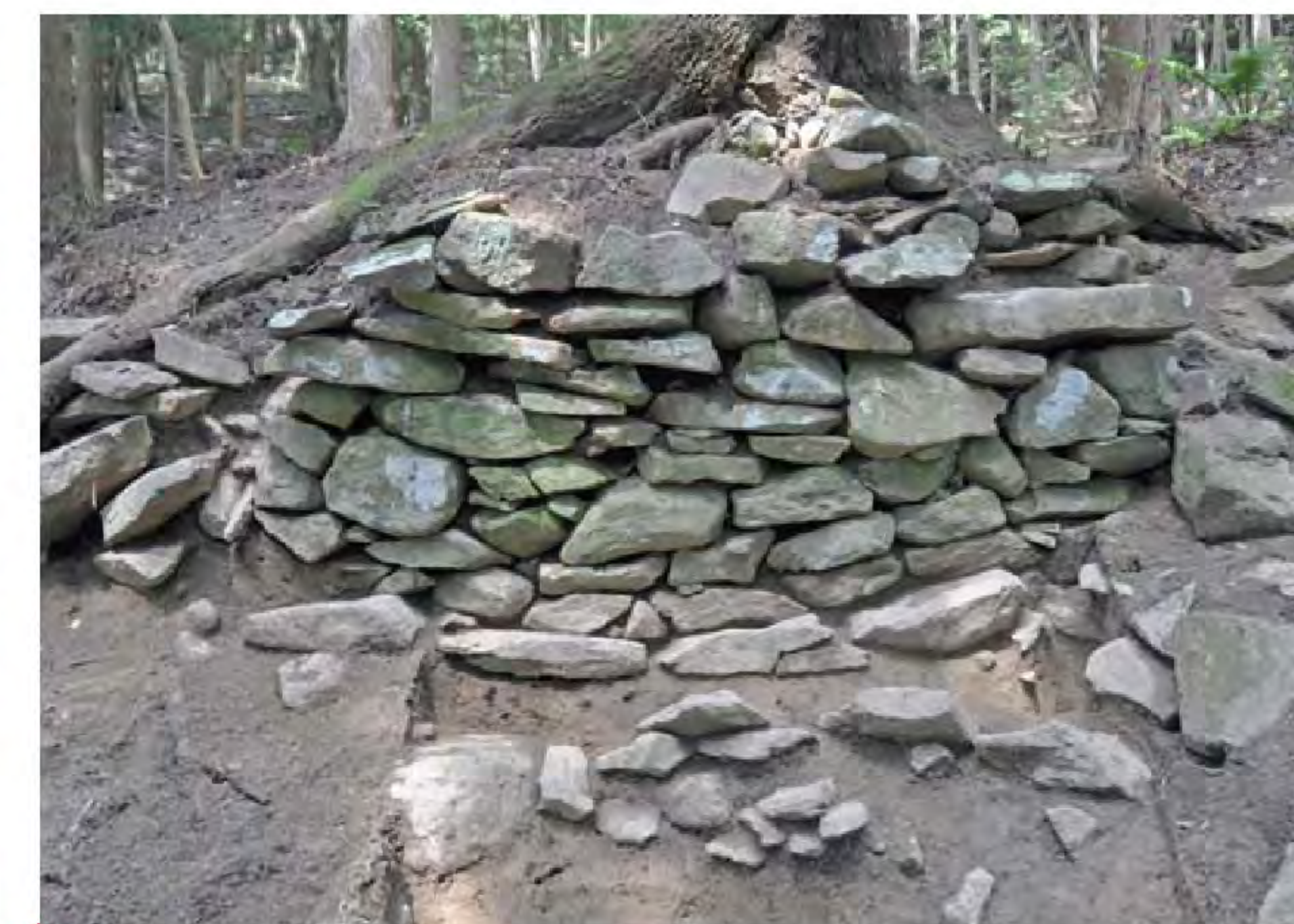
トレンチ 2 の石積みと土台石
