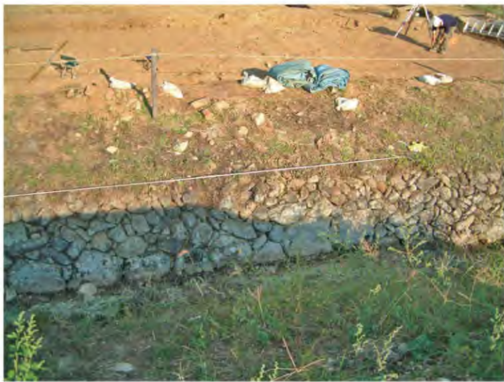
写真6 林山腰遺跡 A 区西面石垣
