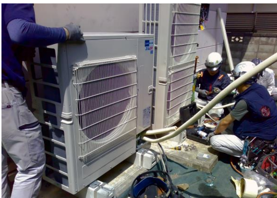
屋外機設置施工中
