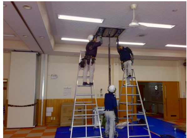
既設屋外機の撤去搬出中
