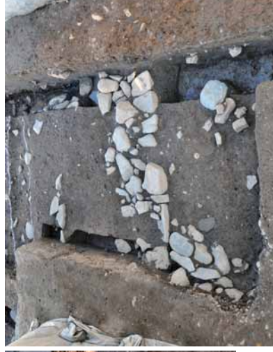
2面 平場法尻の石列 (南から)
