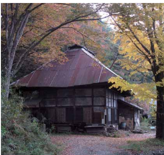
解体前の長安寺本堂
