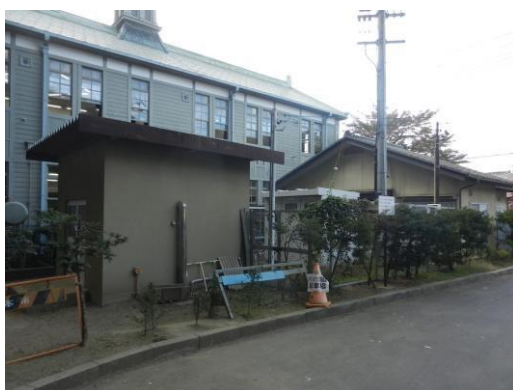
写真3-2 講堂北東側 左：ポンプ室 右奥：倉庫
