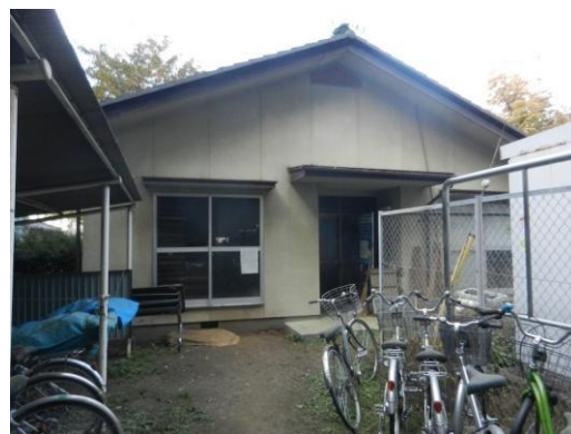
写真3-3 講堂北東側 倉庫
