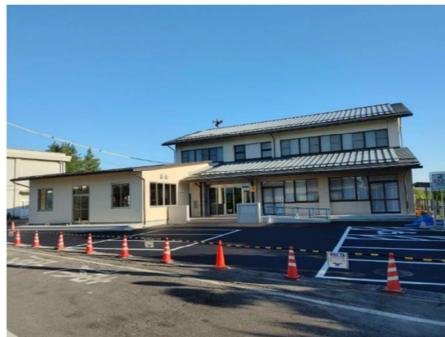
※写真左の会議室が完成した増築部分
