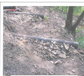
北遊歩道・擬木設置完了
