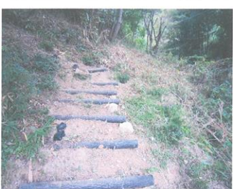
南遊歩道・擬木設置完了
