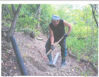
北遊歩道・擬木設置準備作業
