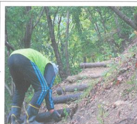
北遊歩道・擬木設置完了
