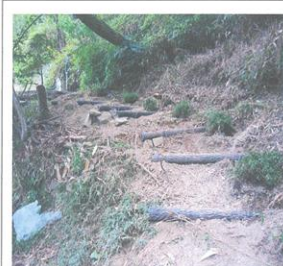
南遊歩道・擬木設置完了
