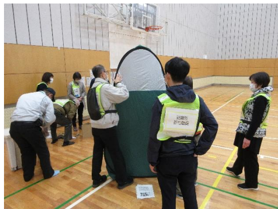
【テントトイレの設置】
