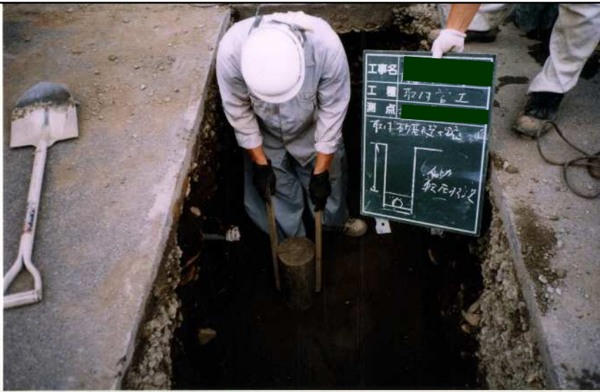
砂基礎埋戻人力転圧状況
