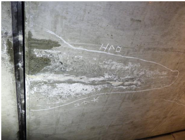
[頂版：局所的なひびわれからの氷柱状遊離石灰]
