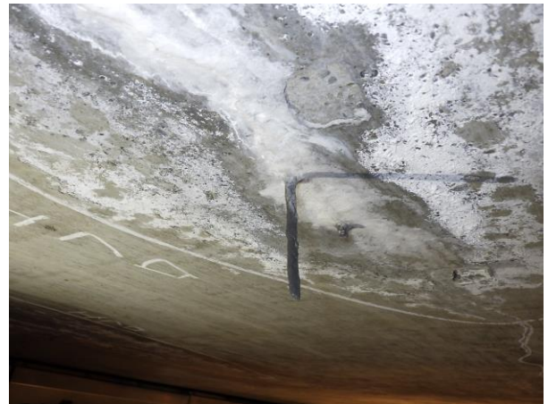
[頂版：局所的なひびわれからの氷柱状遊離石灰]
