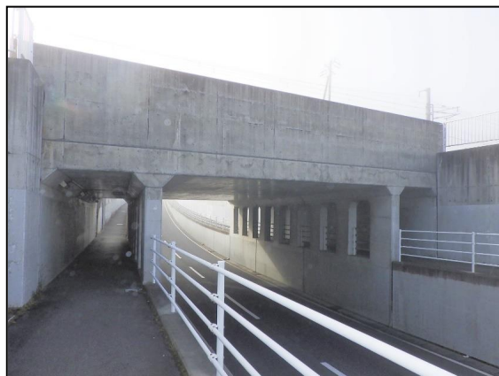
合庁南架道橋（2002竣工）
