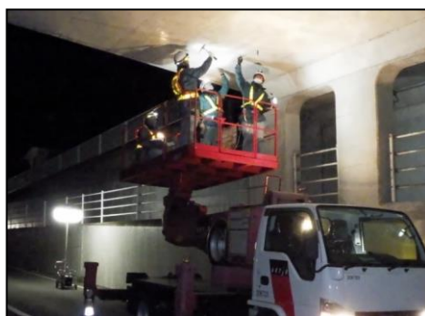
合庁南架道橋 点検状況（令和3年11月）
