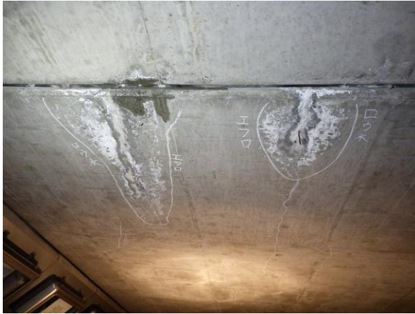
[継手部：顕著な漏水状況]
