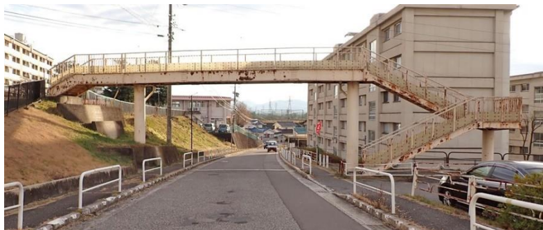
写真 5.1 並柳横断歩道橋
