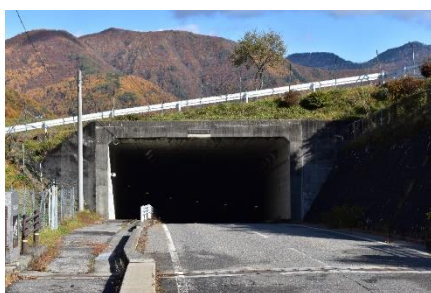
写真-2 雪見ヶ原トンネル全景
