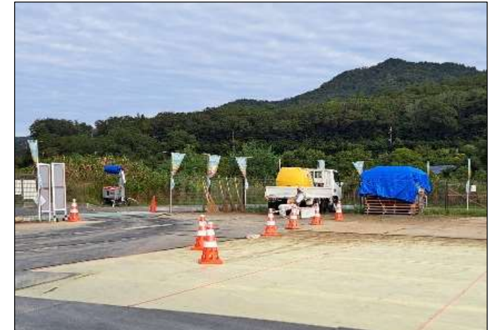
駐車場整備(マット敷設)
