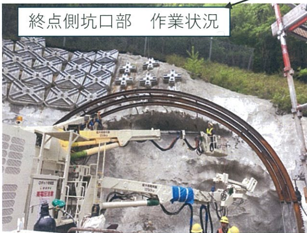
■ 終点側坑口部 支保工設置作業状況
