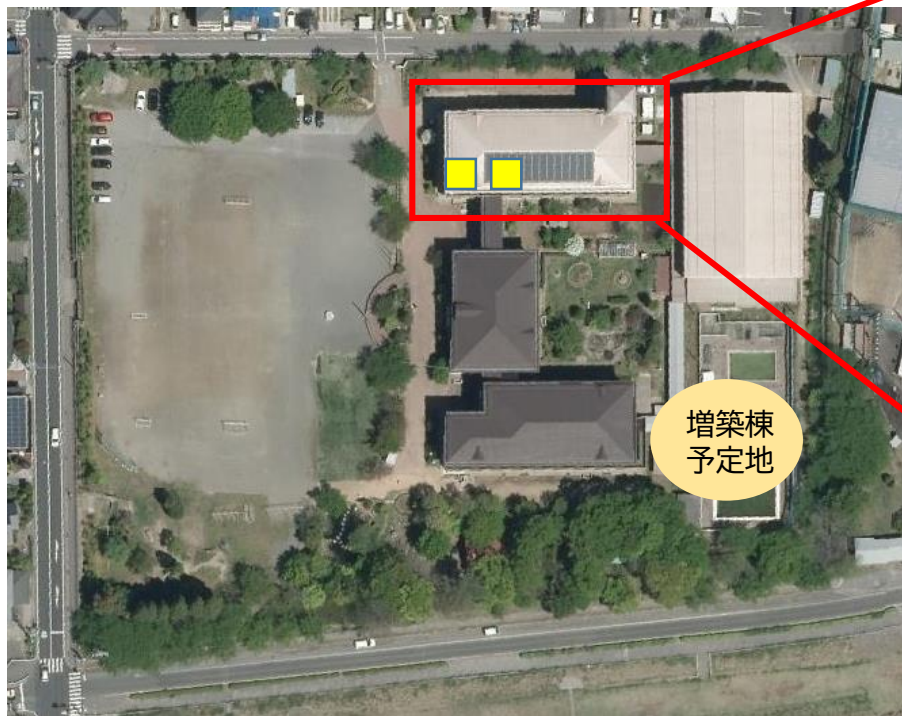
源池小学校航空写真
