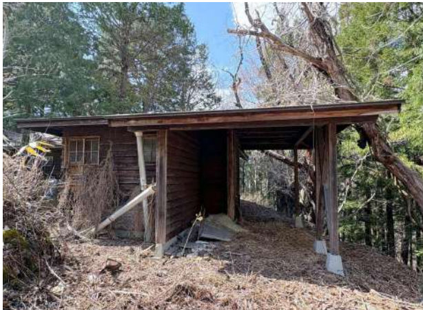
増築便所棟 作業スペース 南面
