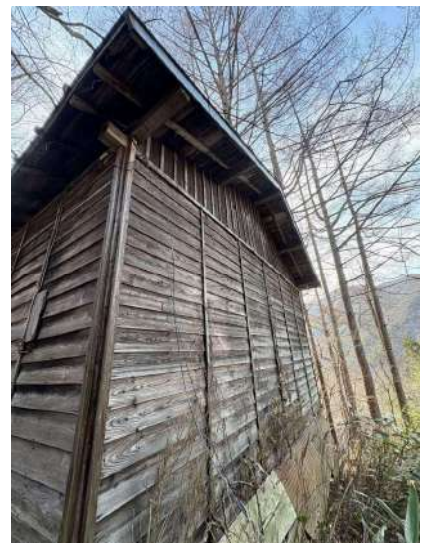
外観：東側の妻壁は板が縦張り
