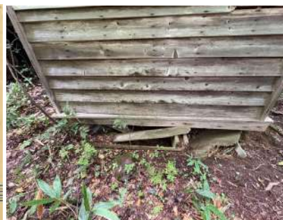
現況の便槽周り
