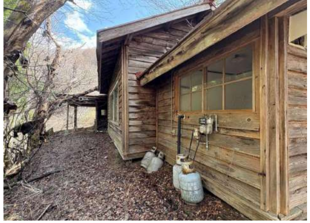
湯呑所、宿直室 東外壁
