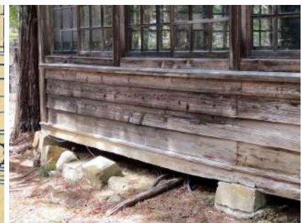
現況の基礎周り
