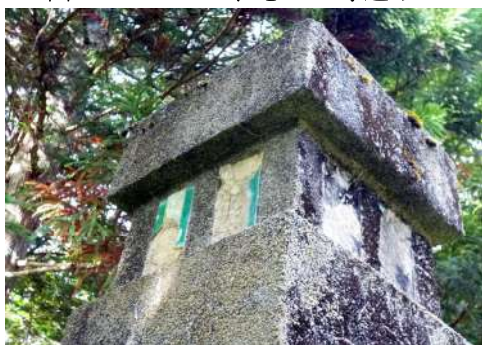
装飾タイルが貼られた洗い出し仕上げの門柱。
