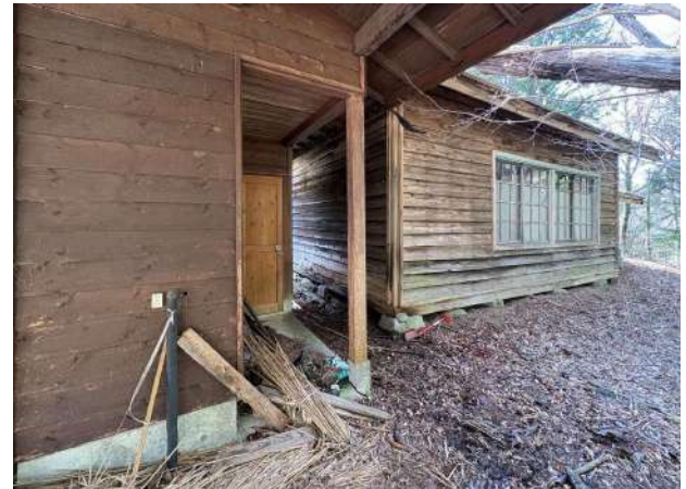
左:増築便所棟作業スペース、右:宿直室 東面
