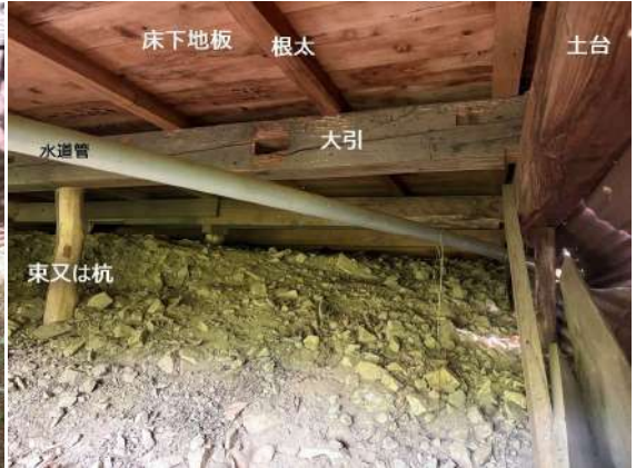
集会所の床下 床組み
