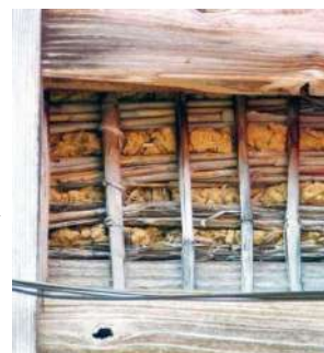
土塗り壁の裏面
