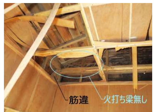
玄関部分の天井裏
