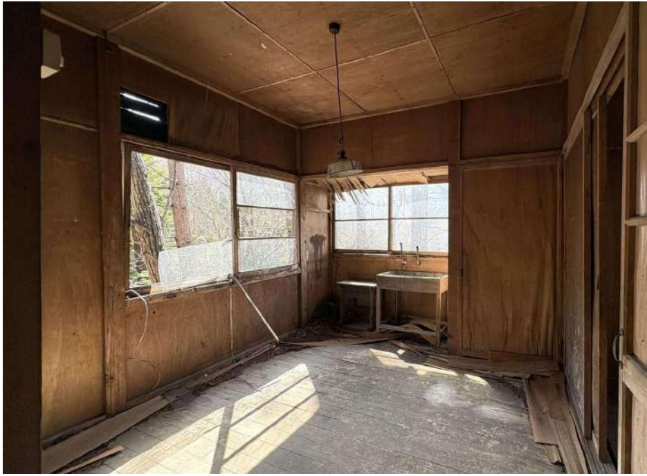
17.旧入山公会堂内観 台所(南東より)
