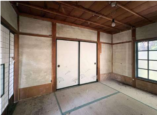
宿直室(北和室) 北東面
