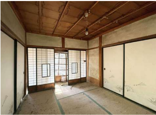
宿直室(南和室) 西北面
