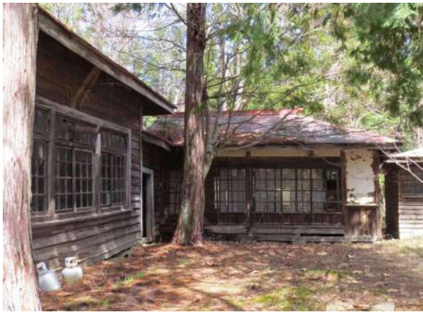
宿直室(左:校舎、右:増築便所棟)
