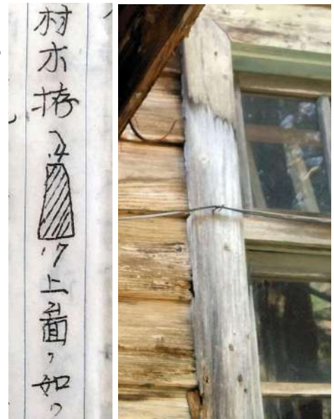
仕様書の書き込みと窓枠の納め
