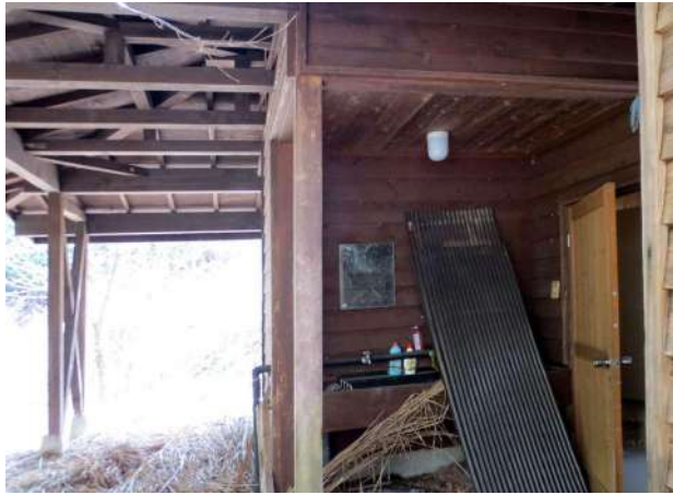
増築便所棟流し
