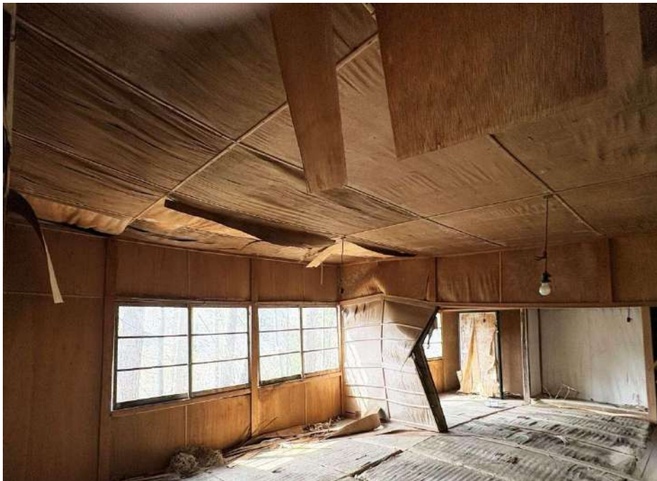
16.旧入山公会堂内観 西側の和室(南西より)
