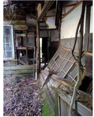
渡り廊下(便所側より)
