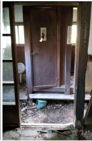
便所前土間(廊下より)
