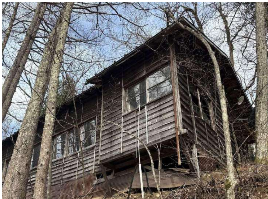
14.旧入山公会堂外観(北西より)
