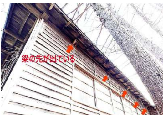
軒桁の外に梁先が見えている
