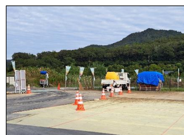
駐車場整備（マット敷設）
