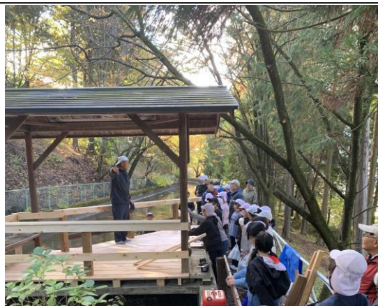
(東屋補修作業の様子)
