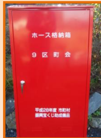
整備した消火栓ホース格納箱
