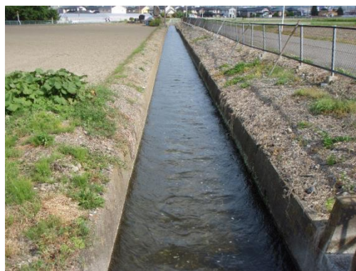
三面コンクリート水路
