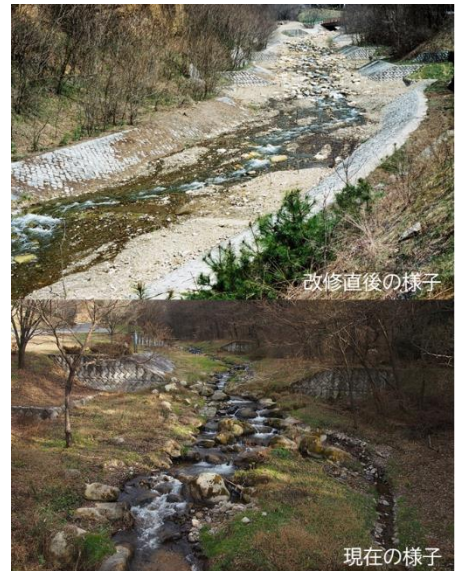
牛伏川橋周辺のえん堤改修部
