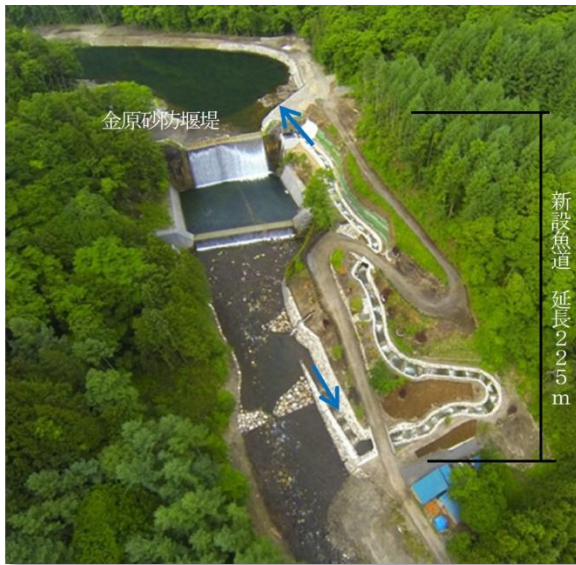
金原砂防えん堤魚道（松本砂防事務所）
