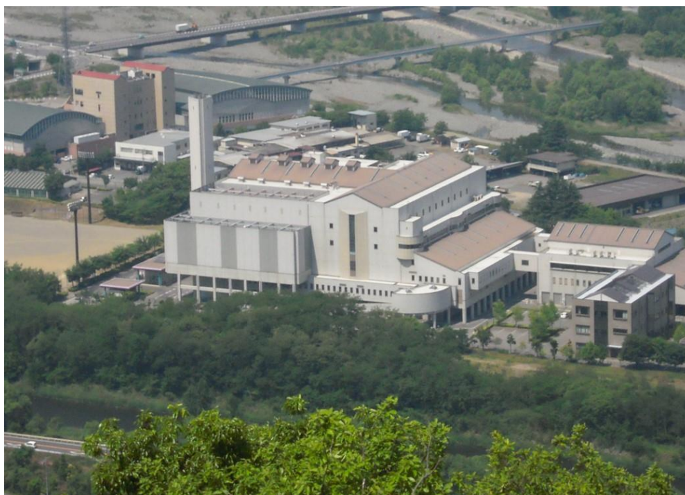
松本クリーンセンター
