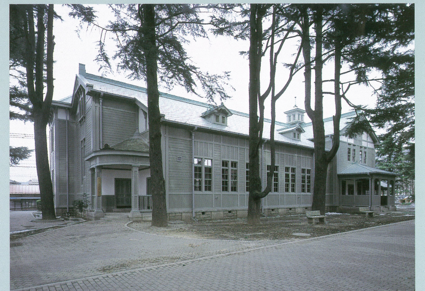
講堂 全景 (西南面より)
