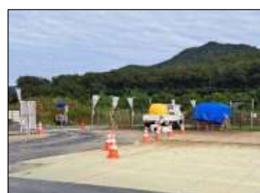
駐車場整備（マット敷設）
