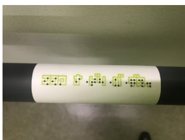
点字と一体となったサイン(左:トイレ案内、右:手すり) 視覚障がい者などにも配慮した色分け
