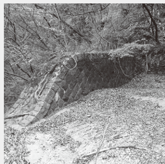
堰堤頂部:アーチ型の石積み
