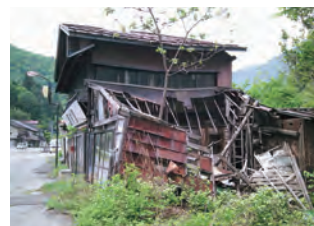
基礎や柱が腐朽し、家屋の一部が崩壊した空き家
