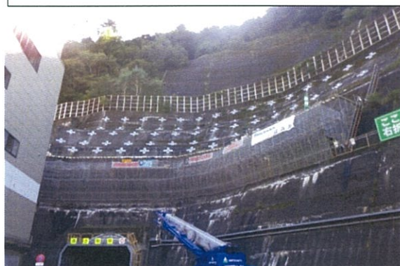
新入山隧道ダム側坑口部 法面補強状況
