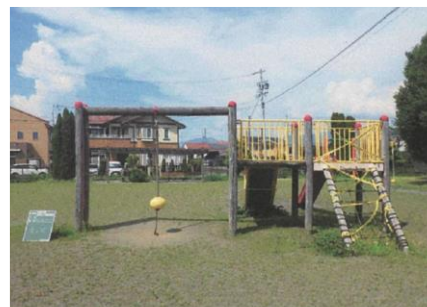
遊戯施設 遊具の更新
