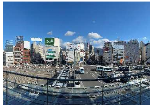
未掲出も散見され、建物老朽化で荷重の課題がある屋上広告物
