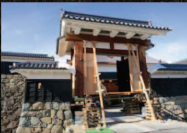
二の門耐震対策工事の様子
