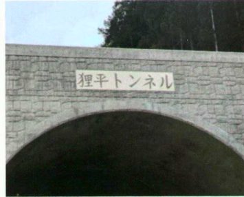
掲げられたトンネル銘板
