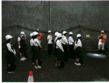
工事現場見学
