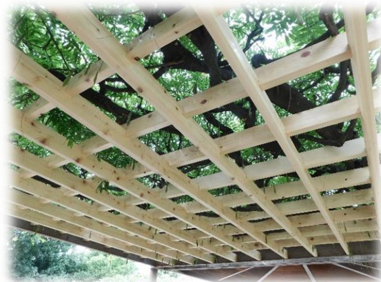
市民の憩いの場として生まれ変わった藤棚（修繕後）
