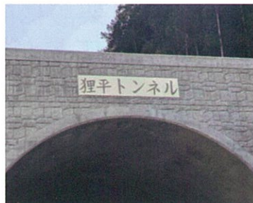
掲げられたトンネル銘板
