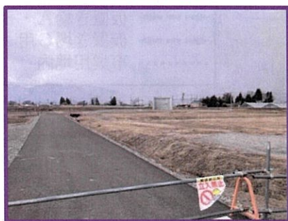
工事用道路整備
