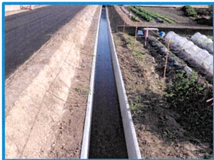
用排水路整備
