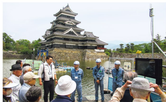
▲お堀に注目! 浚渫船が水面で作業中です
