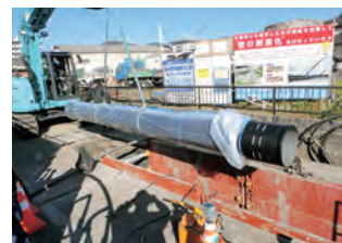
配水管の耐震化工事の様子
