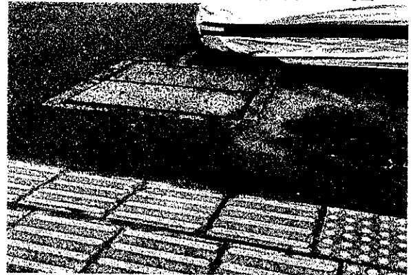
6 2町会内で2系統の排水溝が交わり1町会へ
