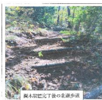
擬木設置完了後の北遊歩道
